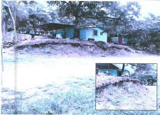
Foto 1: Mejoramiento de muro mas modulo de gradas a un costado del campo.
