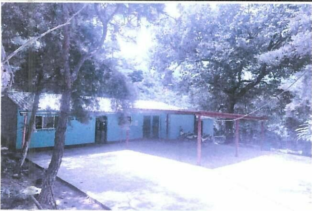
Foto 3: Mejoramiento de techo de patio medidas de 6 x 6
