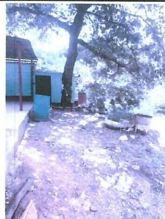
Foto 2: Mejoramiento de losa de patio frente a la cocina a un costado del patio de la escuela. 20 metros de largo por 2 metros de ancho
